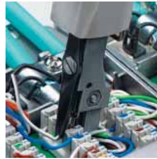
Kablonun tek bir işlemde bastırılarak yerleştirilmesi ve kesilmesi
